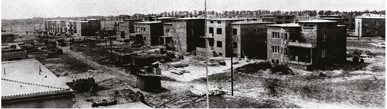
Osiedle Kasztelanów/Abisynia w budowie, widok na ul. Kasztelańską w 1936 roku. Źródło: Kurier Poznański, 12 lipca 1936 roku.
